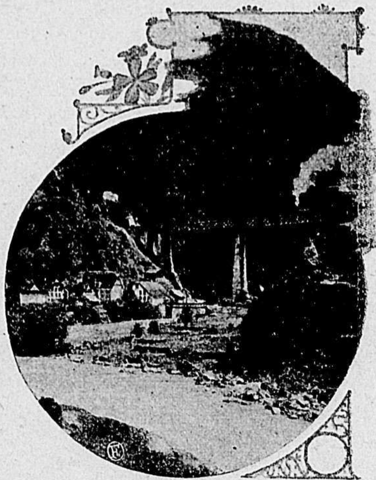
Viadotto presso Amsteg.
