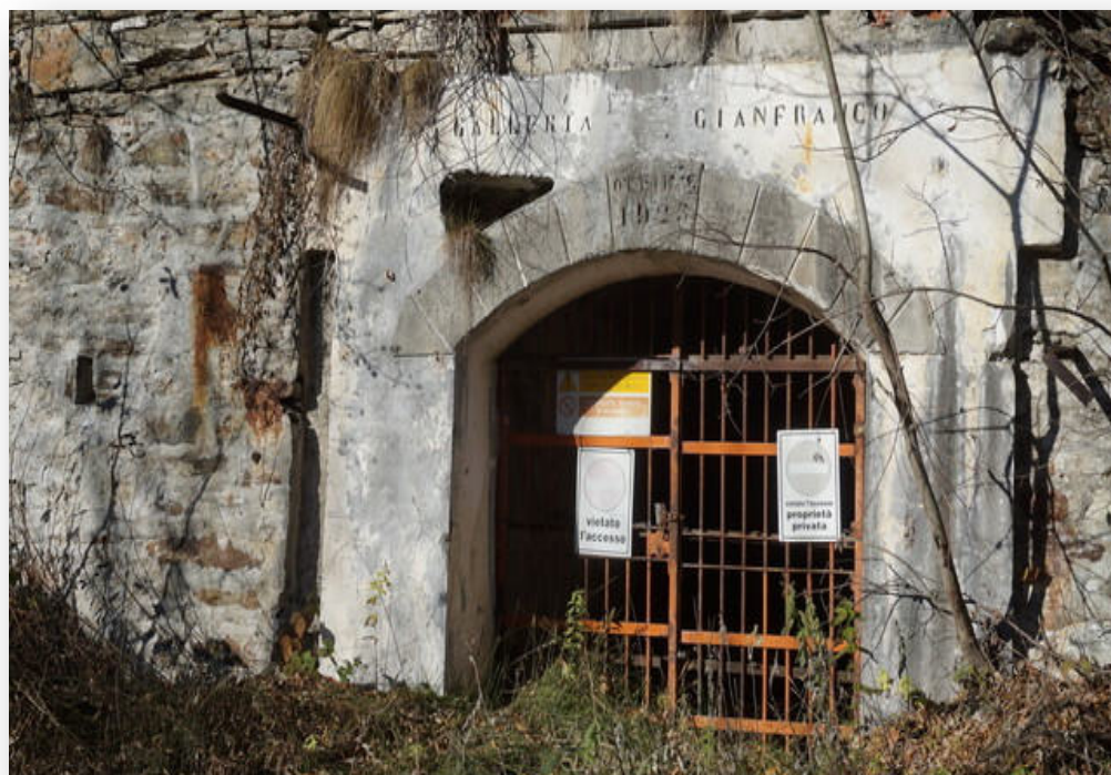
L'ingresso sbarrato alla galleria Gianfranco
