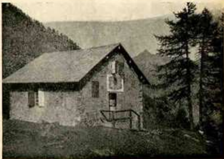
Rifugio Sociale Pier Gioacchino Tocco di Castellazzo.
